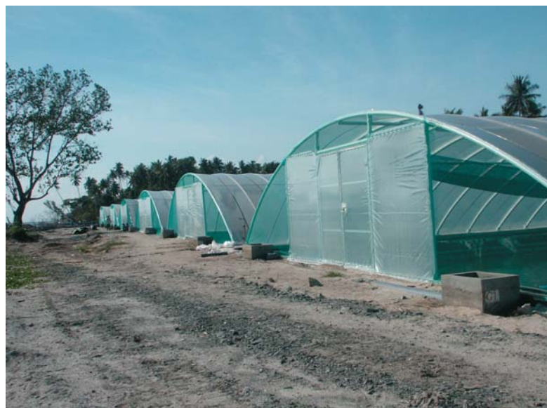
沙巴州纳闽建立了全马首座企业式温室塑胶地膜池养殖系统。
